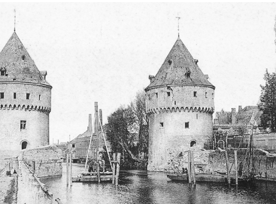
De beschadigde Broeltorens. Arbeiders werken aan de aanleg van een voetgangersnoodbrug.
